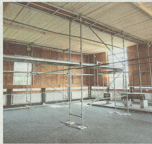
Baustelle Kirchenraum: In der Auferstehungskirche wurde vorübergehend eine Zwischendecke eingezogen, damit die Bauarbeiter die Arbeiten am Dach bewerkstelligen können.
